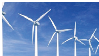
Sumber: ensiklopedia.com Gambar 5.15 Kincir angin ini mengubah energi kinetik angin untuk memutar generator listrik
